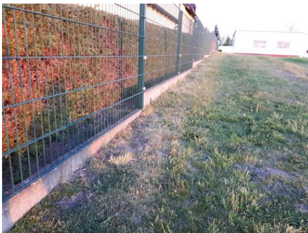
Zaun mit Sockel – nicht überwindbar für Amphibien
